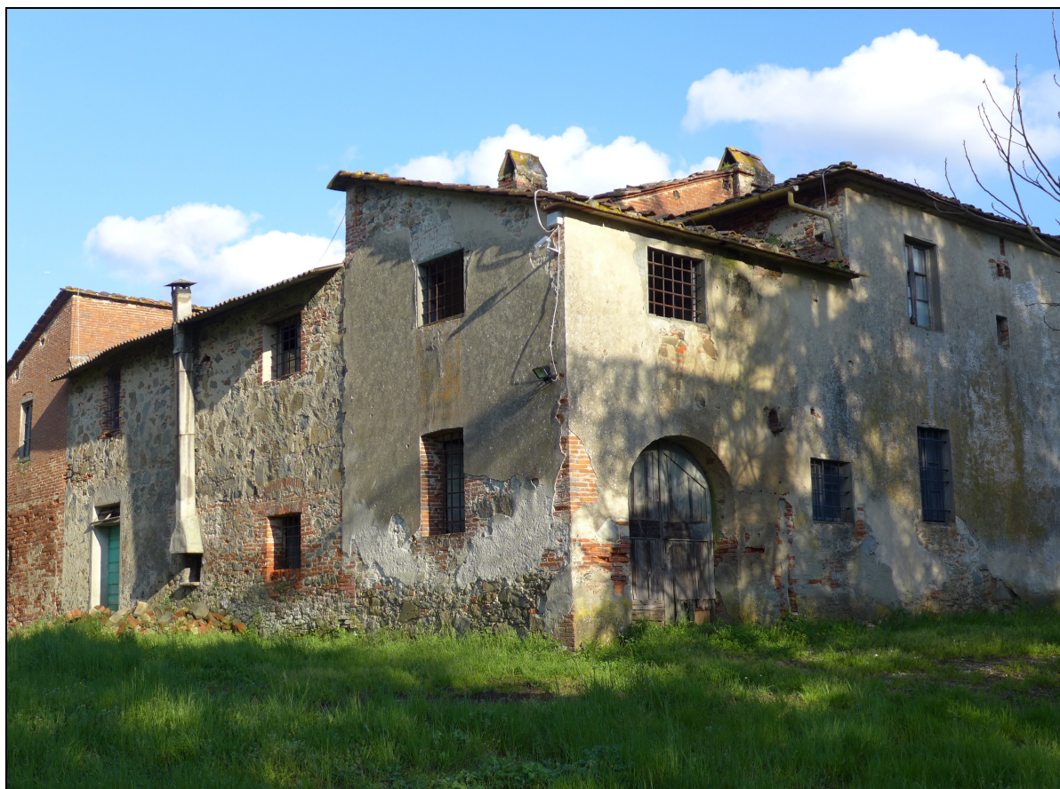
Immagini 10 e 11 - Fotografie dei tre singoli edifici: edificio principale, prospetti laterali
