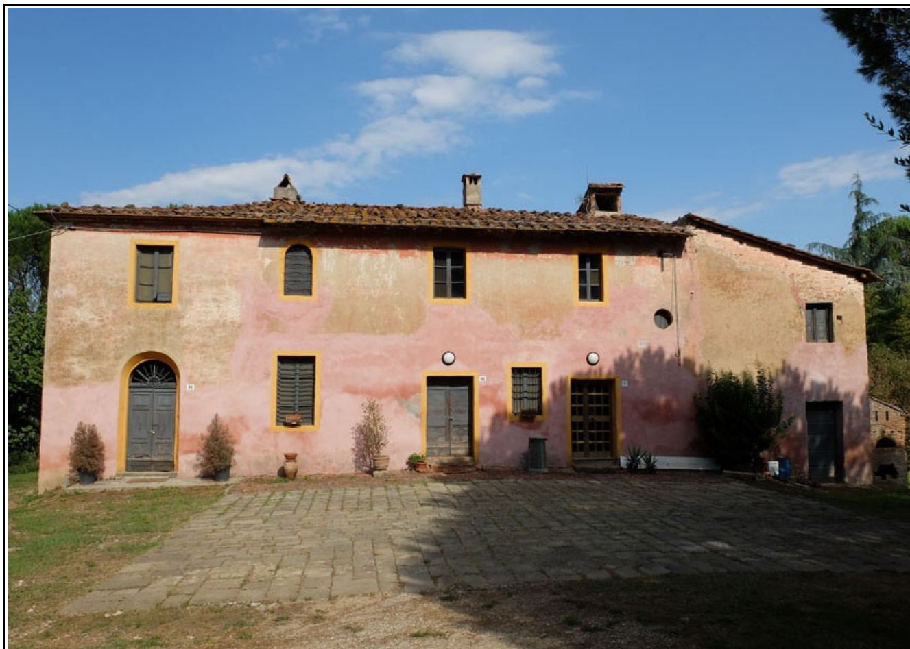
Immagini 38, 39, 40 e 41 – Pavimentazione in pietra del cortile
