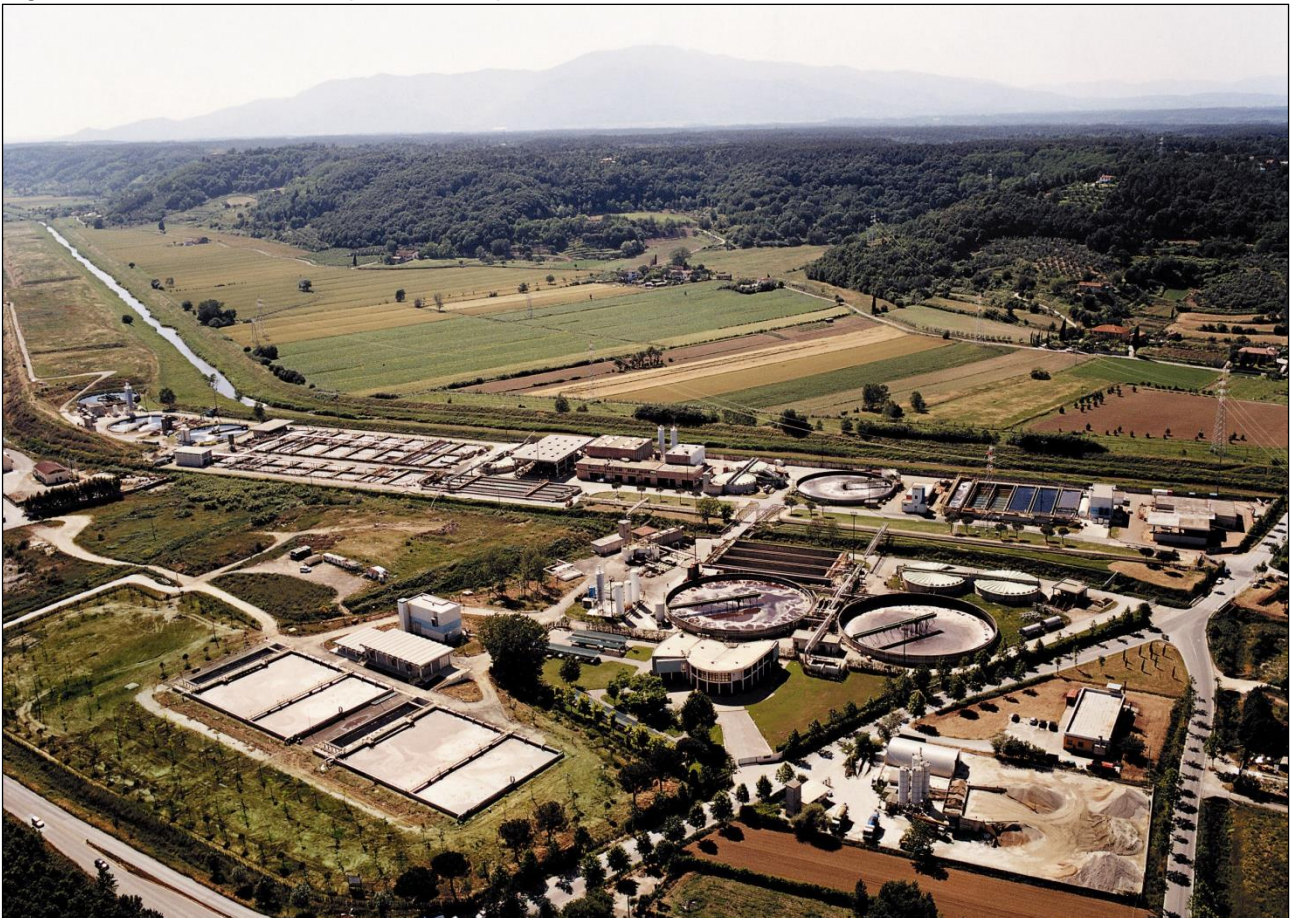
Figura 11. Panoramica depuratore Aquarno.
