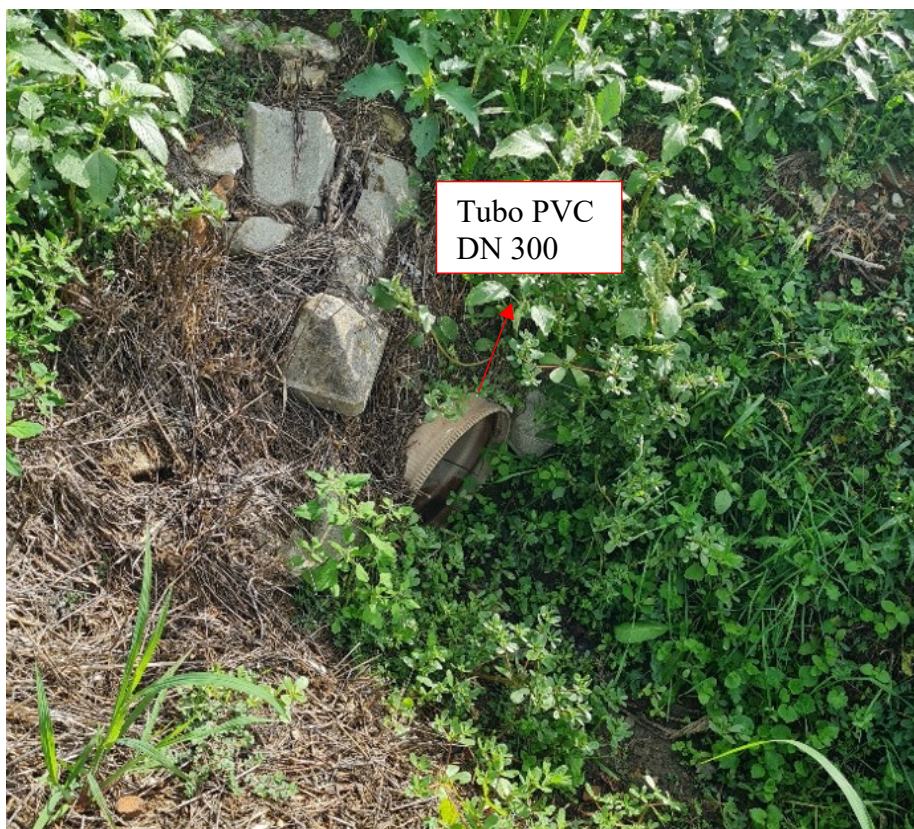
Figura 6 – Tubo PVC DN300 rilevato in fase di sopralluogo.
