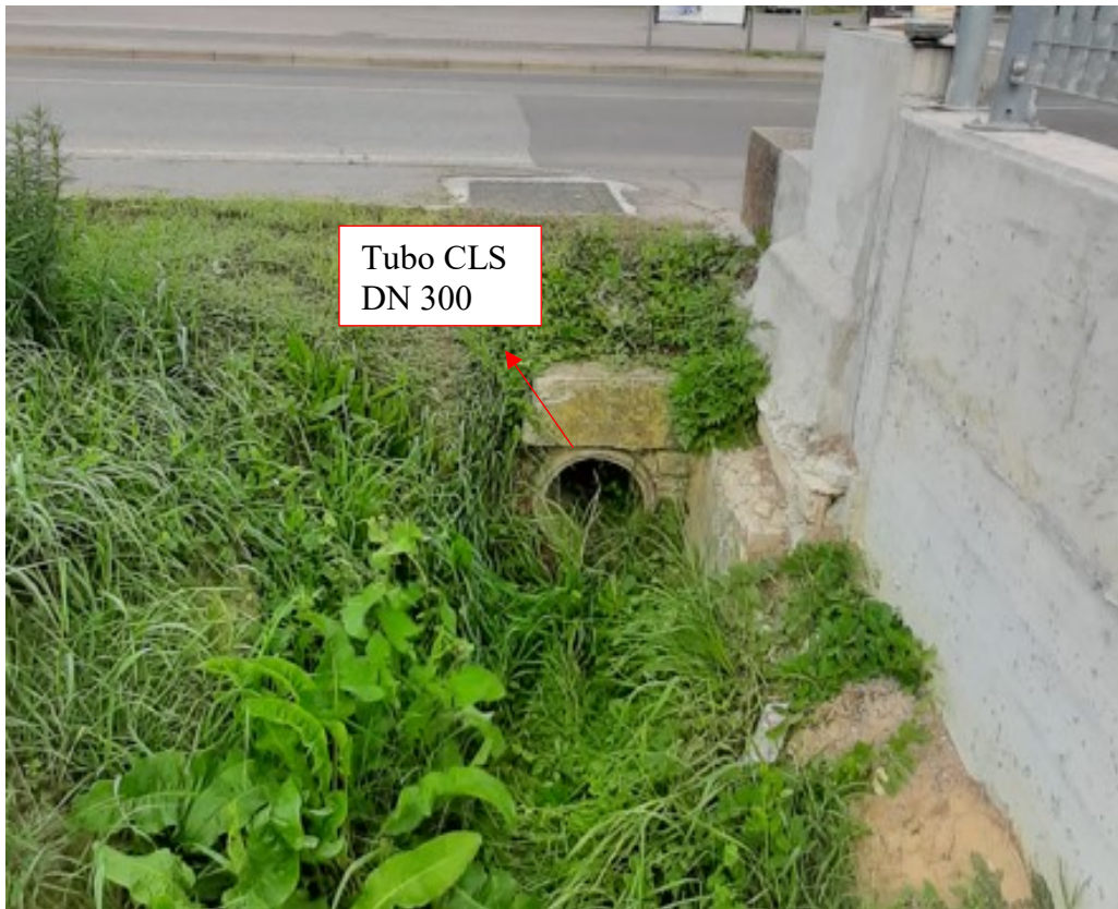
Figura 3 - Tubo CLS DN300 rilevato in fase di sopralluogo.
