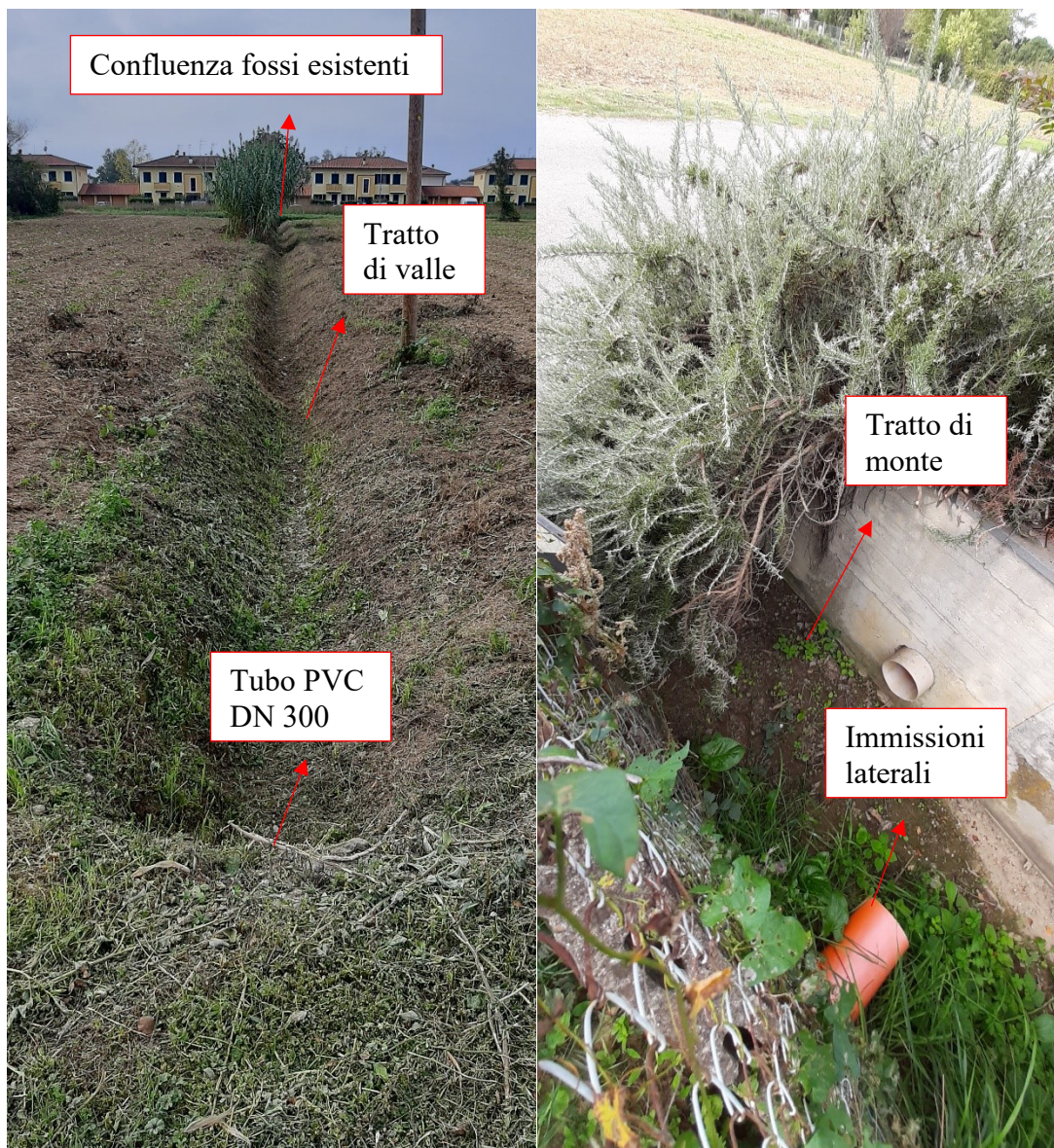
Figura 7 – Particolare tratto monte-valle del tubo PVC DN300 rilevato in fase di sopralluogo.
