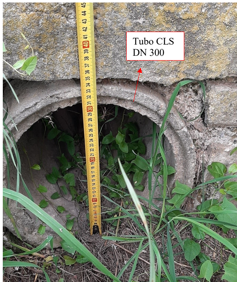
Figura 4- Tubo CLS DN300 rilevato in fase di sopralluogo.
